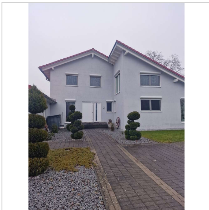
Haus mit Anbau vorn
