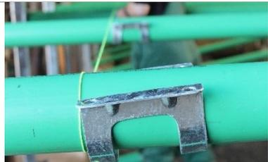
Setzen Sie den unteren Teil des Beschlags auf beide Endrohre und verwenden Sie Maurerschnur, um die Platzierung an den übrigen Rohren zu markieren. Klemmen Sie evtl. zuerst den Beschlag fest.
