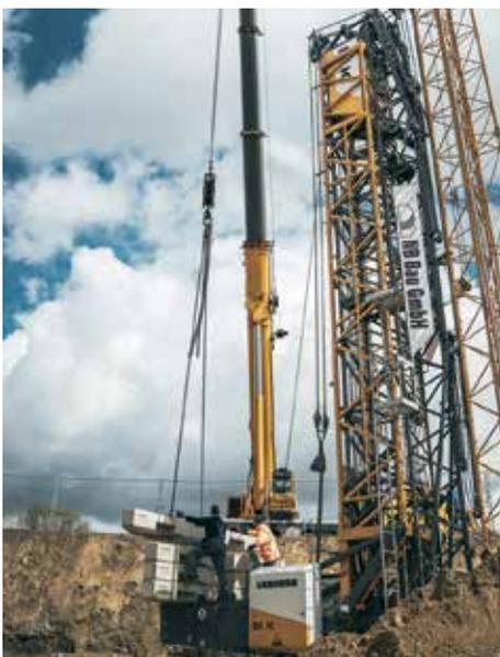
◀ Ein Autokran legt den Ballast des Turmdrehkrans auf der Montagefläche ab.
