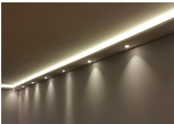
Indirekte Deckenbeleuchtung mit LED Streifenband.
