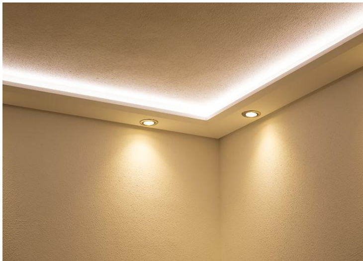
Indirekte Deckenbeleuchtung mit LED Streifenband.
