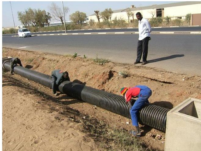
\*عندما يتم التركيب في الجو الحار يجب ردم الماسورة مباشرةً بعد التركيب لقليل عملية التمدد الذي قد يؤدي إلى تحريك الخلطة قبل تمسكها.
