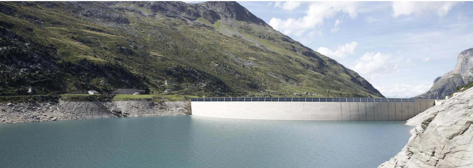
ewz baut eine weitere hochalpine PV-Anlage auf der Staumauer Lago di Lei der Kraftwerke Hinterrhein AG (KHR). Die Anlage mit über 1000 PV-Modulen wird jährlich rund 380 MWh Strom produzieren. Die erste hochalpine PV-Grossanlage der Schweiz Solar Albigna ist seit mehr als einem Jahr in Betrieb und erfüllte alle Erwartungen insbesondere auch bei der Winterproduktion. Photovoltaik-Panels sind in alpiner Lage hocheffizient und tragen zu einer verlässlichen Stromversorgung im Winter bei.
