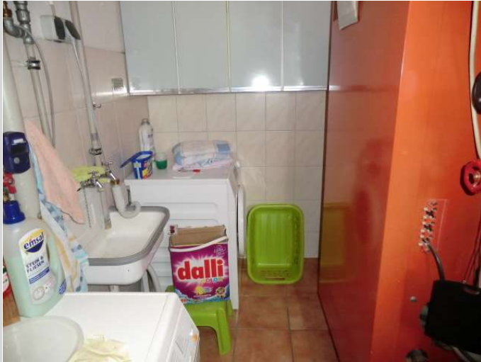
Heizung und Waschraum für OG
